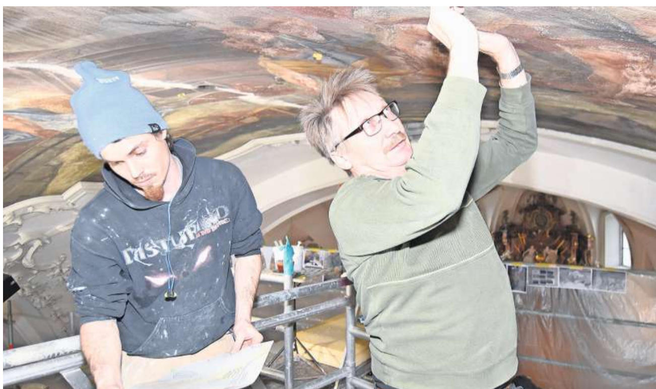
Chefrestaurator Wendel Odermatt (rechts) klopft ein Gemälde nach Hohlräumen ab, während Lorenz Stöckli auf eine Kartierung des Deckengemäldes schaut.
